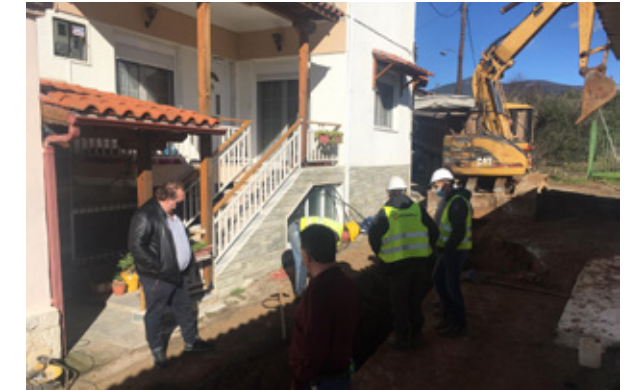
Ο αντιδήμαρχος Σπύρος Γαντάς επιθεωρεί τις εργασίες κατασκευής του αποχετευτικού δικτύου.
